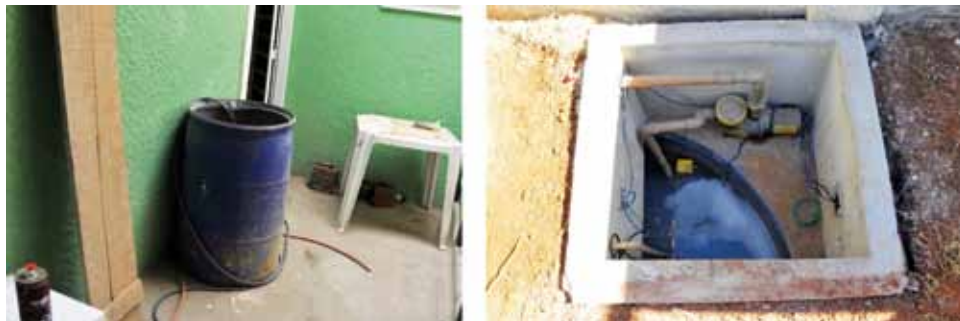
Figura 13. Depósitos de água ao nível do solo.
